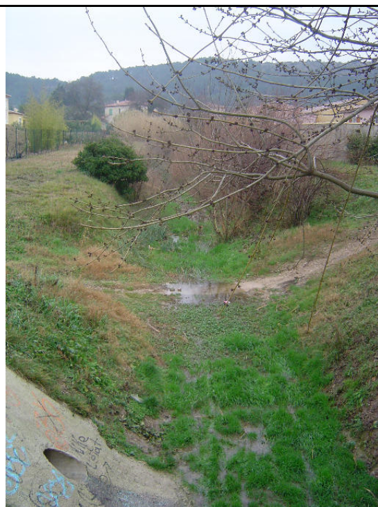
Ravine collecteur d'eau pluviale des lotissements
